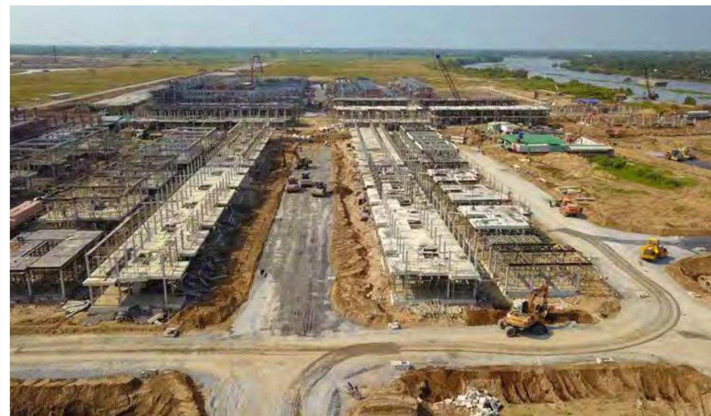
Tiến độ xây dựng Khu đô thị Waterpoint tháng 12/2019
