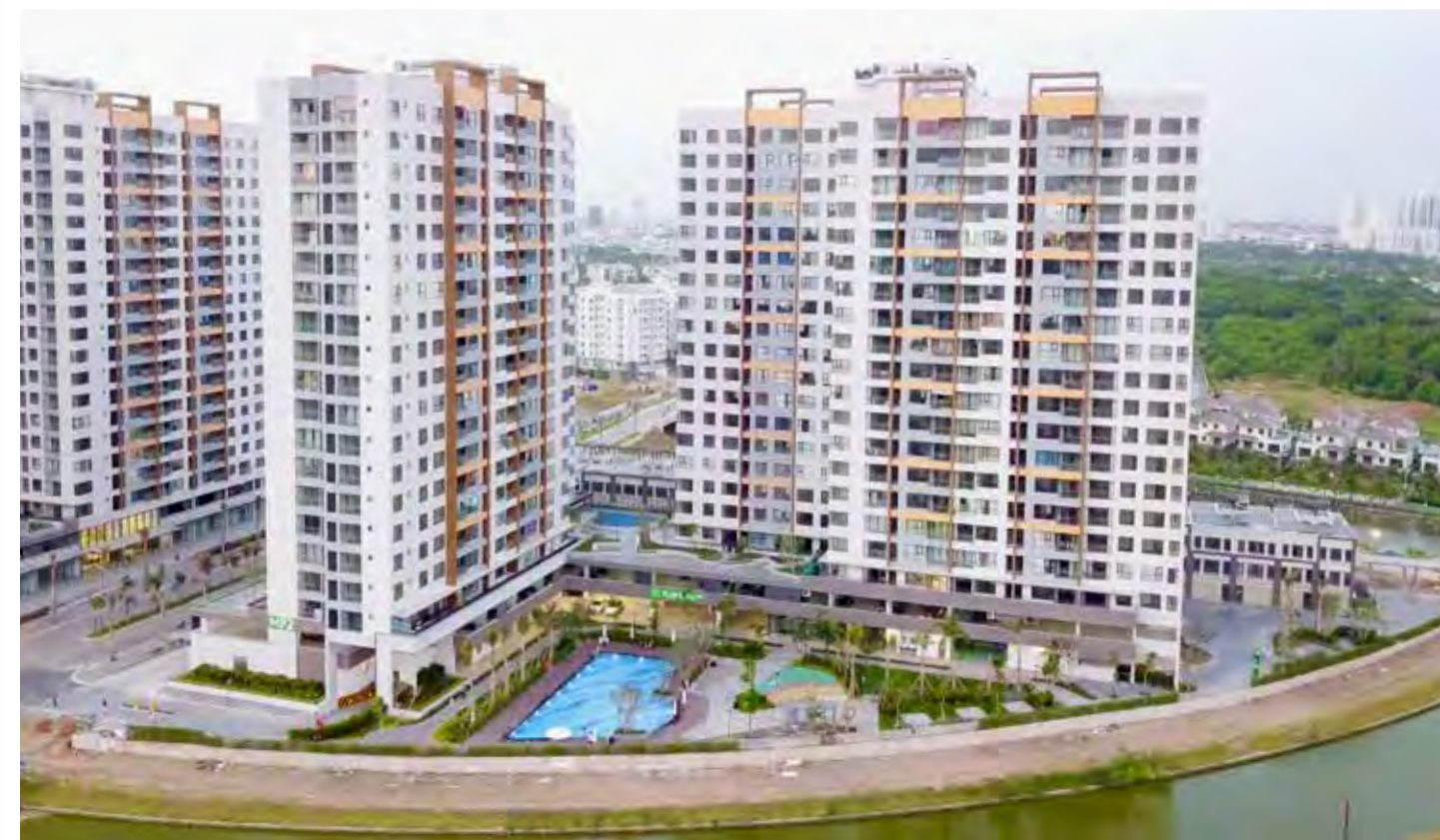
Tiến độ xây dựng Khu đô thị Mizuki Park tháng 12/2019
